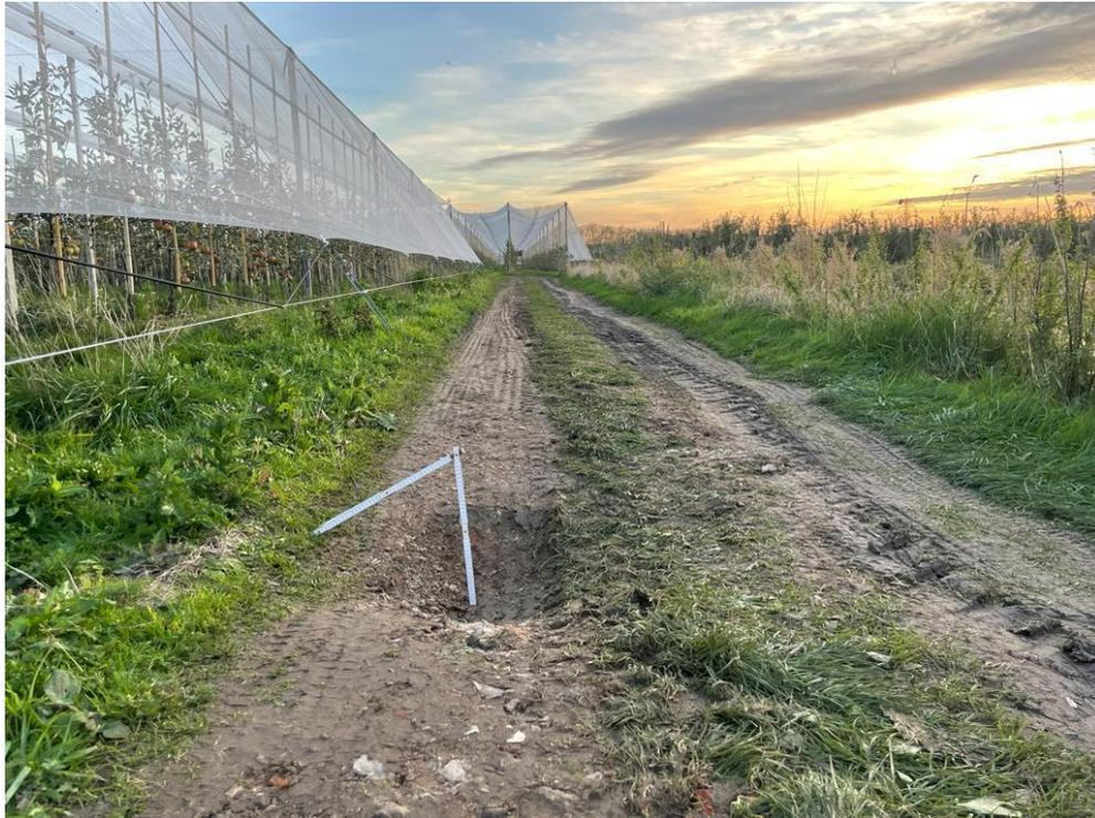
Abbildung 31: Exemplanische Absackung eines Fahrweges im Stadtteil Neuenfelde, Bezirk Harburg. Quelle: N. Stehr, 2023.
